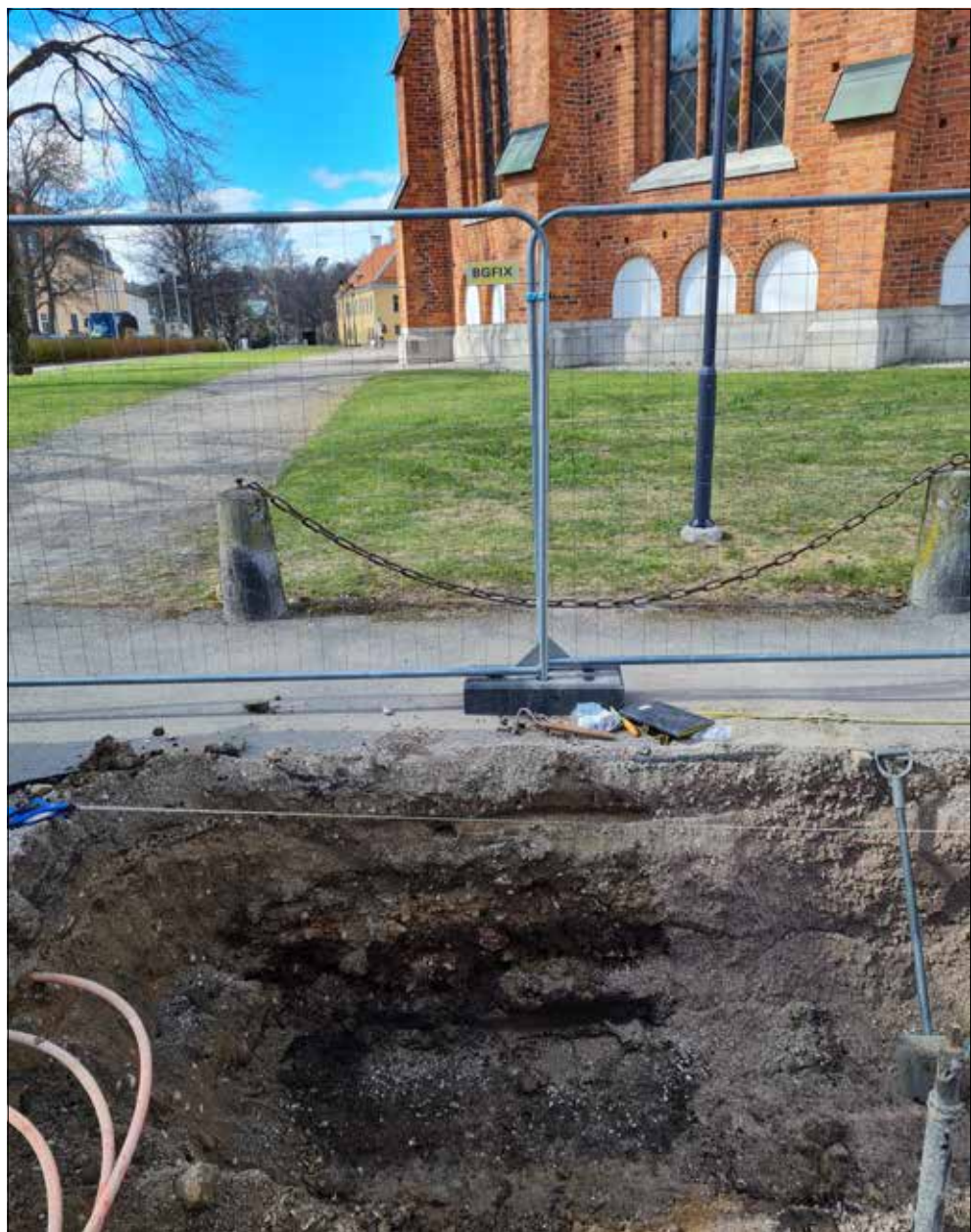
Figur 31. Schakt 5 togs upp öster om Västerås domkyrka. Foto Oskar Spjuth från nordöst.
