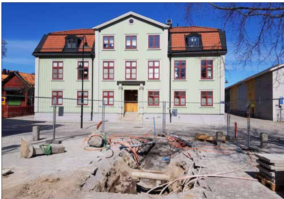
Figur 9. Schakt 1 togs upp på den södra sidan av Skolgatan. Östra Kyrkogatans föregångare, som idag är representerad av en gång- och cykelväg på den högra sidan av schaktet, har anslutit till Rektorsgatan som ses till höger i bild. Foto från söder.
